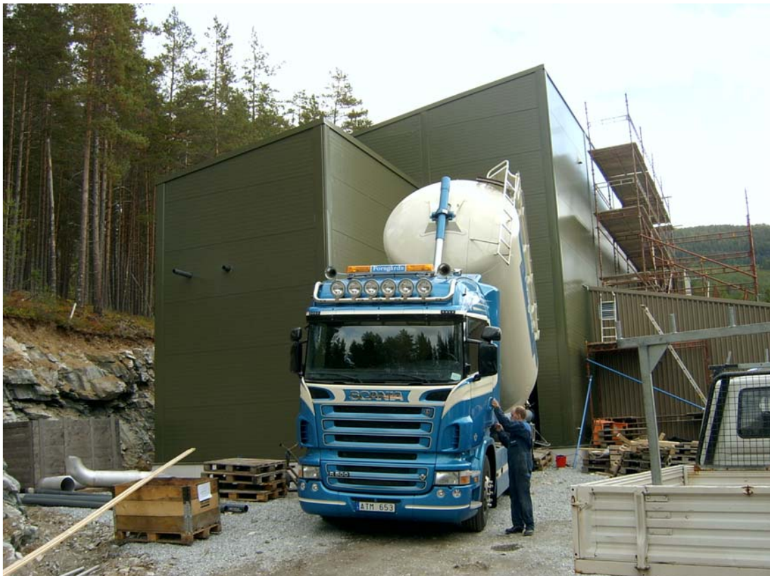
Levering av filtersand til nytt fargejerningsanlegg på Vangestad, september 2008
