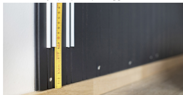
Fest innfestingsklipsene i spileplaten
