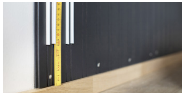
Fest innfestingsklipsene i spileplaten
