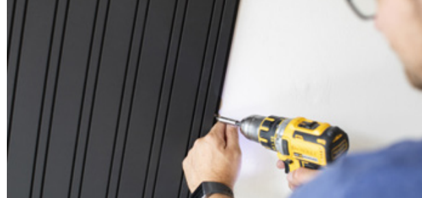
Monter Easy spileplate på vegg
