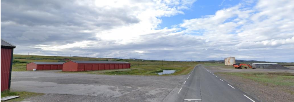
Figur 34: Snøscootergarasjer til vestre i bildet, parkeringsplass for bilder har ifølge lokale skjedd på andre siden av veien foran gravemaskinen på bildet (Google, 2023)
