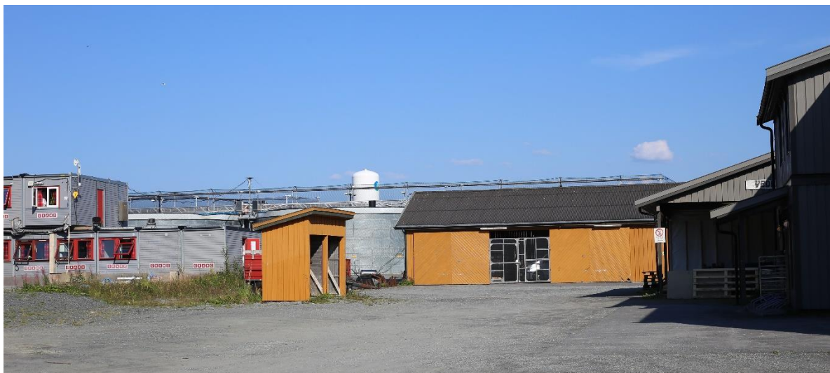
Figur 11 Deler av bygningen til Dønna Asvo til venstre med lager for tømmer, brakkerigg er tilknyttet utbygging ved Fishbase. Kilde: Multiconsult
