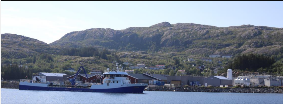
Figur 14 Deler av anlegget til Fishbase (Multiconsult).
