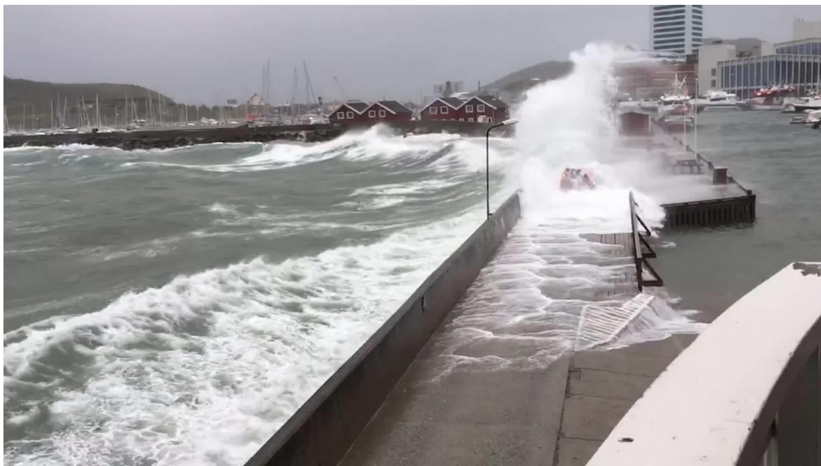
Figur 4 Eksempel på overskylling i Bodø under stormen Sally i 2020 (bølgetilstand H_s=1.4 m / T_p = 4.5 s). Molo ligger på kote +3 m (NN2000). Vannstand var 1.9 m. Gjennomsnittlig overskylling er estimert til 5 l/m/s basert på EurOtop (2018). Største overskyllende enkeltbølger estimert til 600 l/m.
