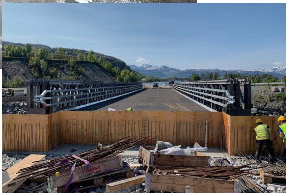
Figur 3.5: Montering av interimbru, om lag to uker før åpning av midlertidig omkjøringsveg. Foto: Ingvild Nylund, Statens vegvesen.
