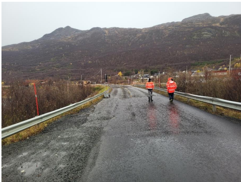
Figur 8.4: Terrenget flates ut og vegen ligger igjen på lett fylling med mindre vegetasjon i høyere sjikt rundt vegen. Foto: John B. Njarga/Statens vegvesen.
