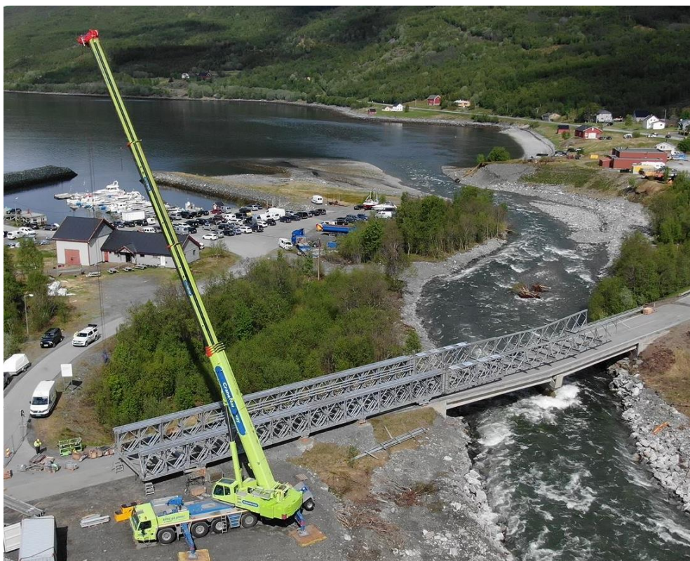
Figur 2.1: Montering av midlertidig bru over E6-brua, vår 2022. Foto: Frode Lyng Hanssen, Statens vegvesen.
