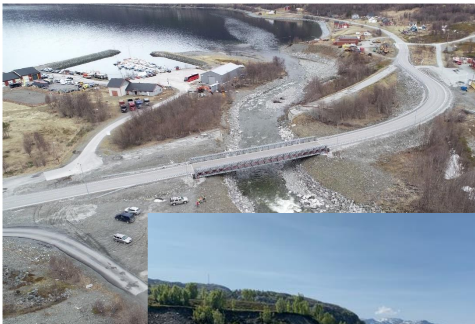
Figur 3.4: Interimsbrua og midlertidig omkjøringsveg. E6-traseen, uten bru, ses i bakgrunnen. (Dronefoto: NVE)
