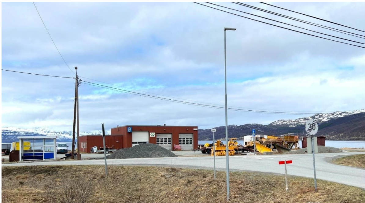
Figur 8.1: Dagens situasjon, med kollektivholdeplass på E6 til venstre i bildet. Fotgjengerovergang, som ender i krysset mot Sætra, går over E6 like til høyre for rød garasje. (Foto: Adrian Masvik, Statens vegvesen)
