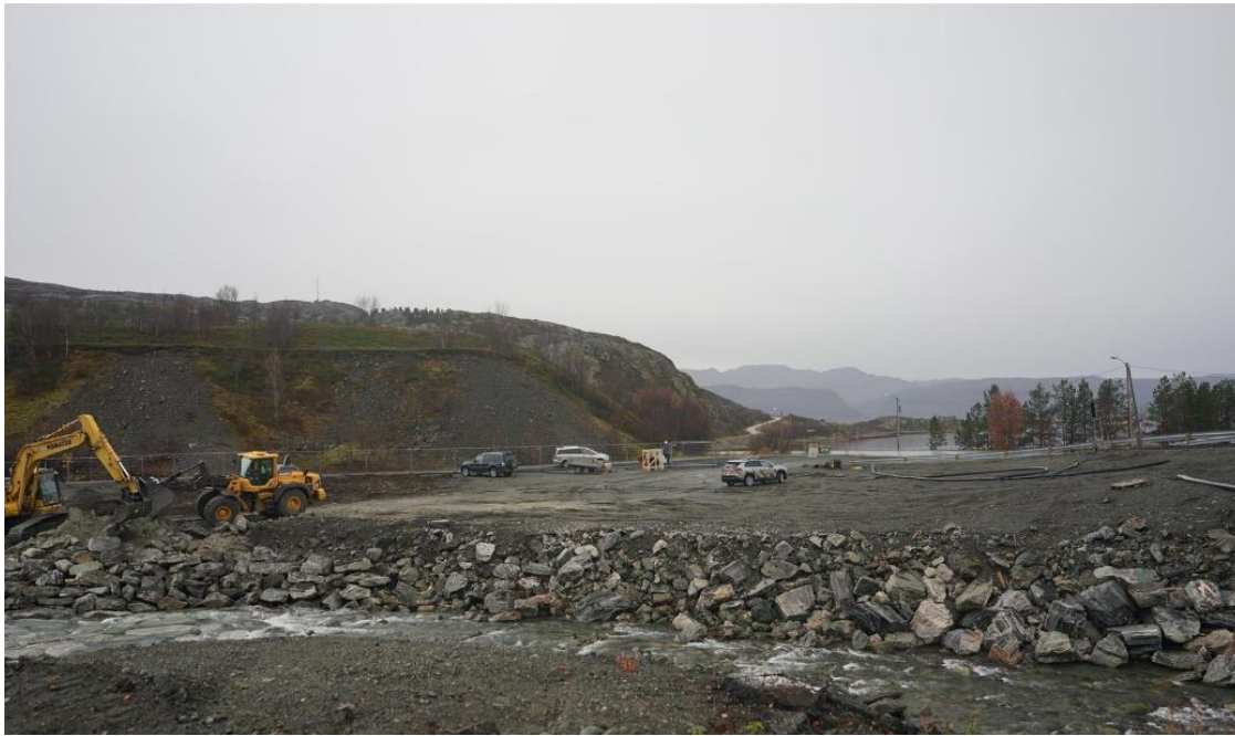
Figur 8.3: Tidligere vegetasjonsdekt område er ryddet, høst 2022. Plastringsarbeid pågår. Morenerygg i bakgrunn. Foto John B. Njarga/Statens vegvesen.
