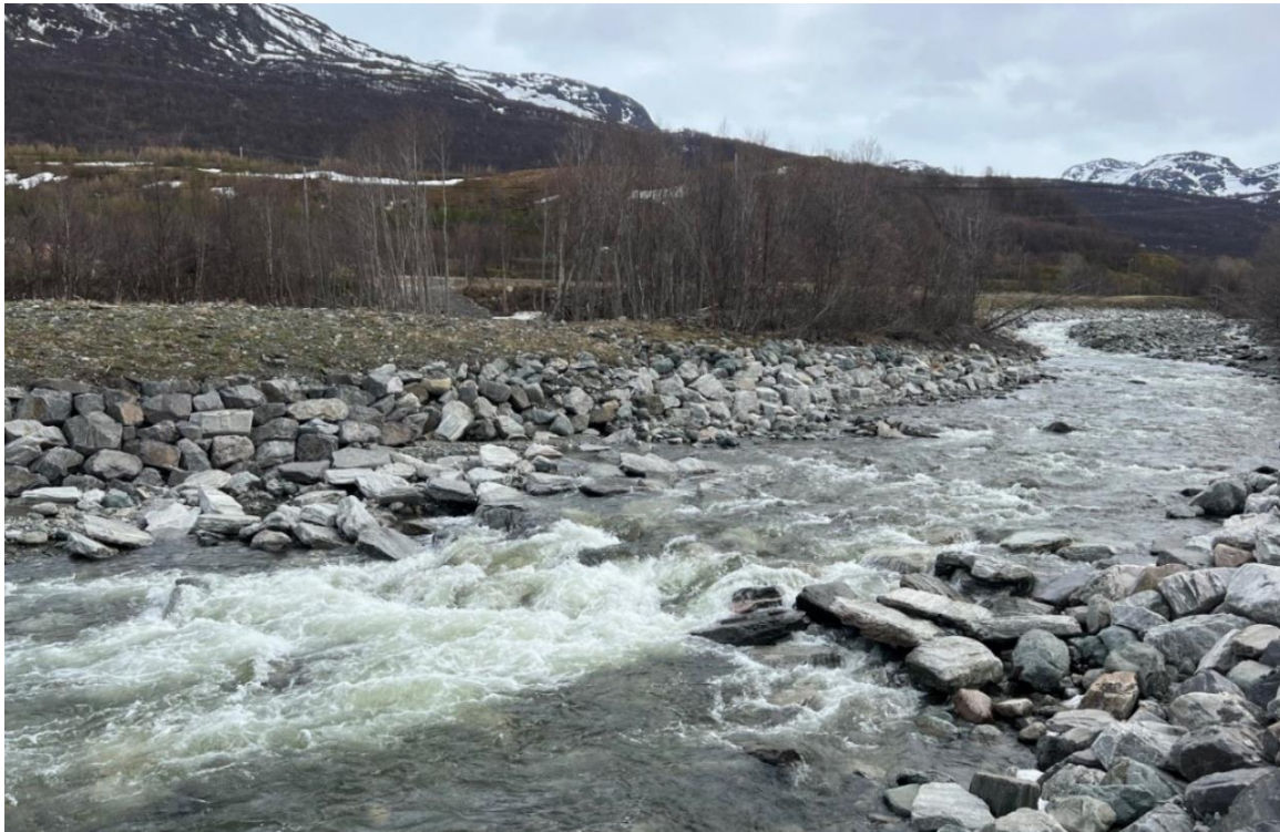
Figur 8.7 Mye av plastringsarbeidet er gjennomført allerede, i forbindelse med bygging av midlertidig omkjøringsveg. (Foto: Adrian Masvik, Statens vegvesen)
