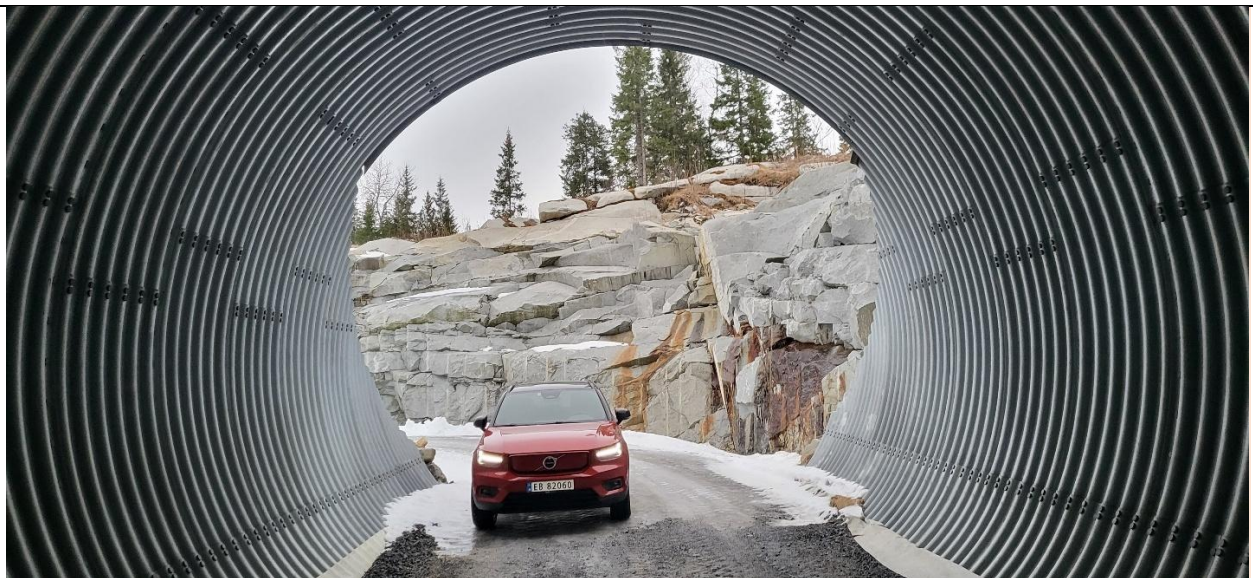
Adkomsten til Gardslia i undergang under E6.
